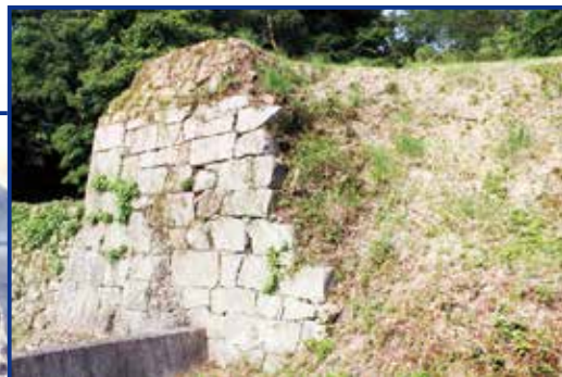
積み直された石垣
