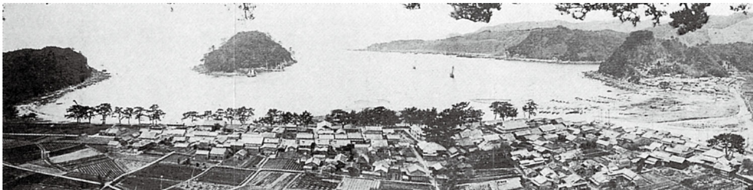
周参見下地浦の全景
