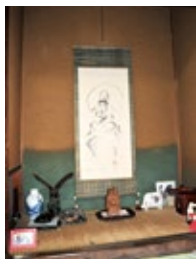
すさみ町周参見の個人宅に残る昭和南海地震津波の浸水痕跡。床の間の壁は津波後に塗り直しましたが、再び痕跡が現れてきたそうです。
