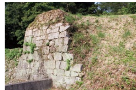
同絵図に描かれた石垣破損場所の現況 (写真提供: 新宮市教育委員会)
