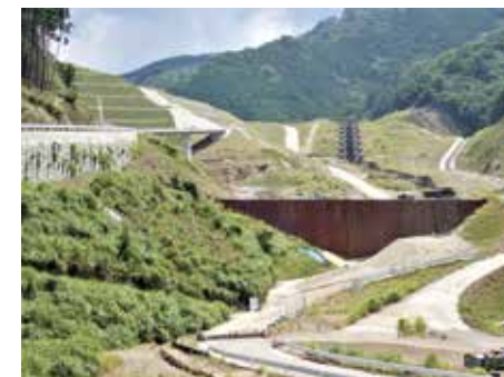
開通した市道(田辺市熊野) 平成23年大水害で、市道は土砂ダムに埋没。新しい市道は土砂ダムを越えて、令和3年7月21日に復旧開通しました。
